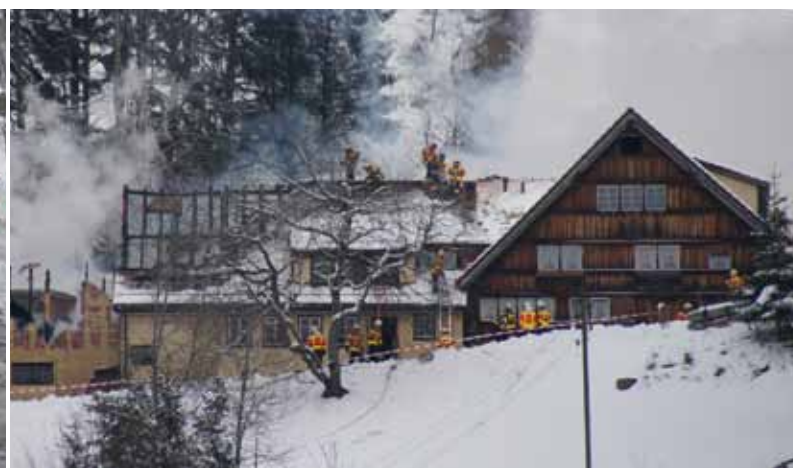
Haltelinie (Schneise im Dach) zwischen Scheune und Haus schneiden... Minustemperaturen, Schnee, Eis... enge, steile Zufahrt... der Scheunenteil ist weitgehend zerstört... das Haus kann weiter bewohnt werden...
