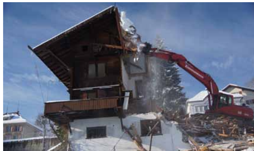
Abbruch der beiden Altbauten...
