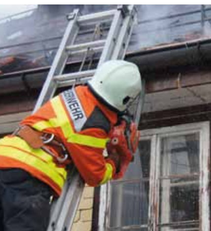
Haltelinie (Schneise im Dach) zwischen Scheune und Haus schneiden... Minustemperaturen, Schnee, Eis... enge, steile Zufahrt... der Scheunenteil ist weitgehend zerstört... das Haus kann weiter bewohnt werden...
