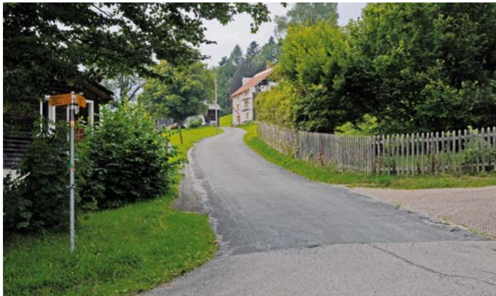
Die Feldstrasse wird vom Pfadiheim bis zum Ahorn instand gestellt. Foto: HS
