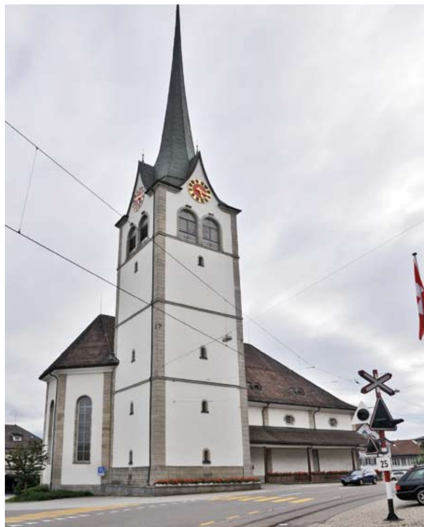
Ortsbild 3: Die Grubenmannkirche markiert das Ortszentrum.
