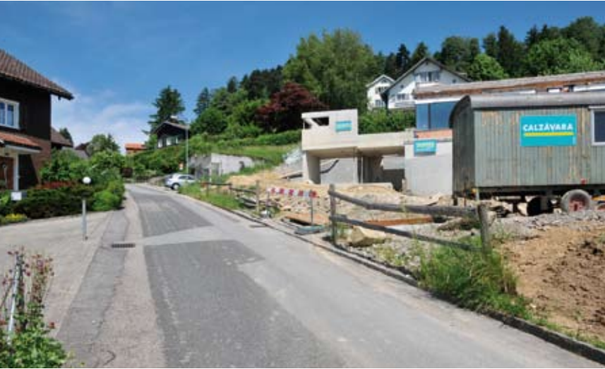
Hier, beim Einlenker in die Fadenrainstrasse, soll die Bündtstrasse geschlossen werden. Foto: GL
