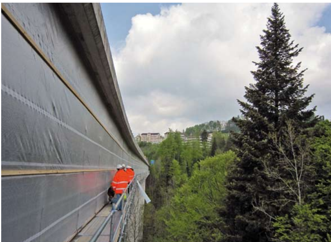
Sanierungsarbeiten an der Leuenbachbrücke. Foto: pd.
