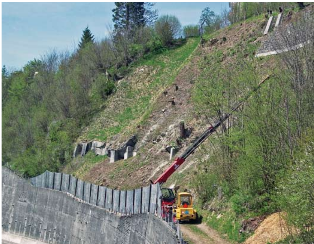
Hangsicherungsarbeiten im steilen Gelände oberhalb der Stützmauer «im Holz». Foto: pd.
