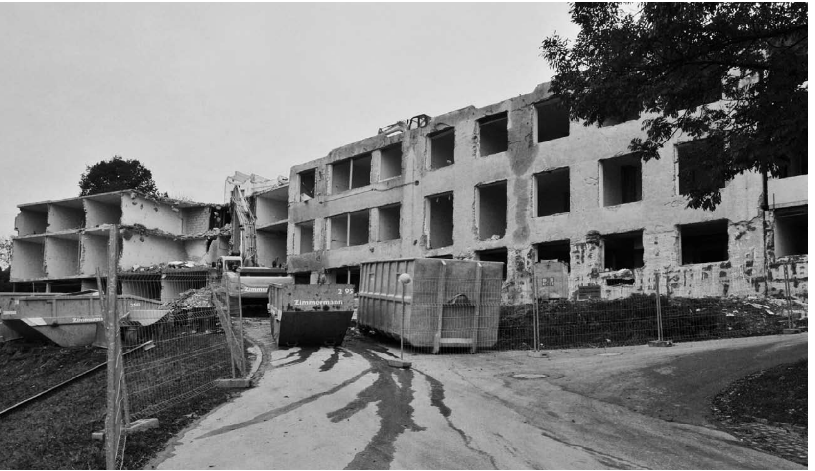
Das frühere Alterszentrum wird «zurückgebaut». – Neu entstehen hier 21 Alterswohnungen. Fotos: GL
