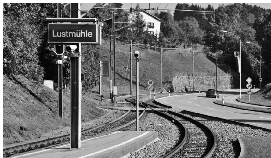
Die Verlängerung der Kreuzungsstelle Lustmühle um rund 400 Meter ist ein Teilprojekt der Durchmesserlinie Appenzell – St. Gallen – Trogn. Fotos: GL
