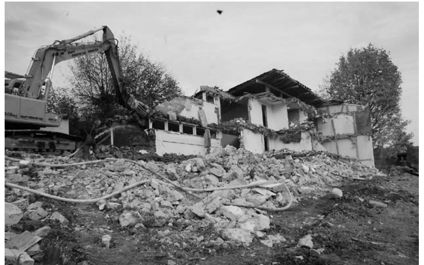
Oktober 2006: Abbruch des Schwesternhauses.
