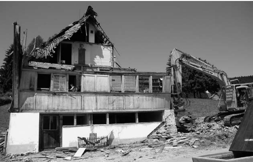
Juli 2006: Abbruch des Bauernhauses der Familie Preisig.
