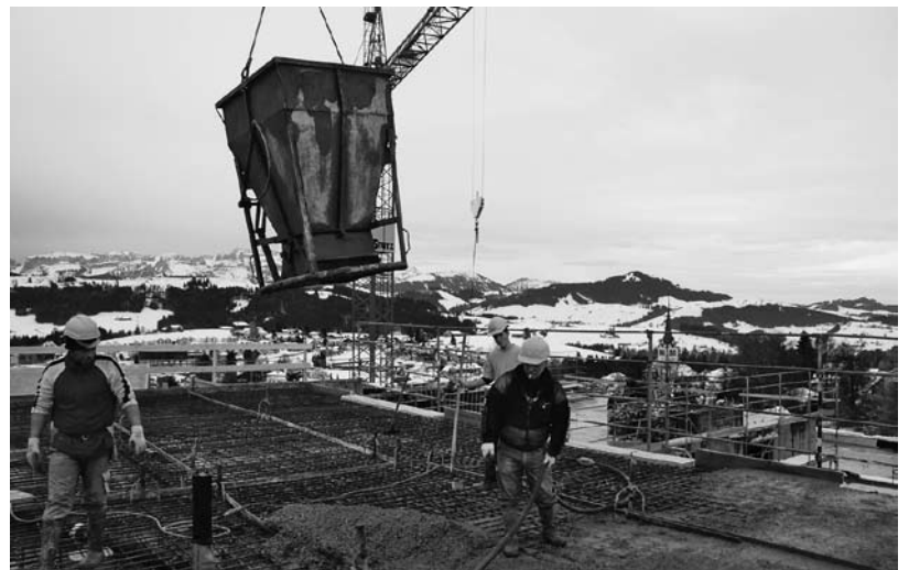
2007: Einbetonierung einer Zwischendecke.
