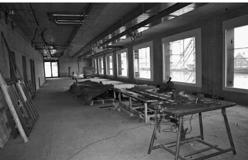
2008: Arbeiten am Innenausbau...
