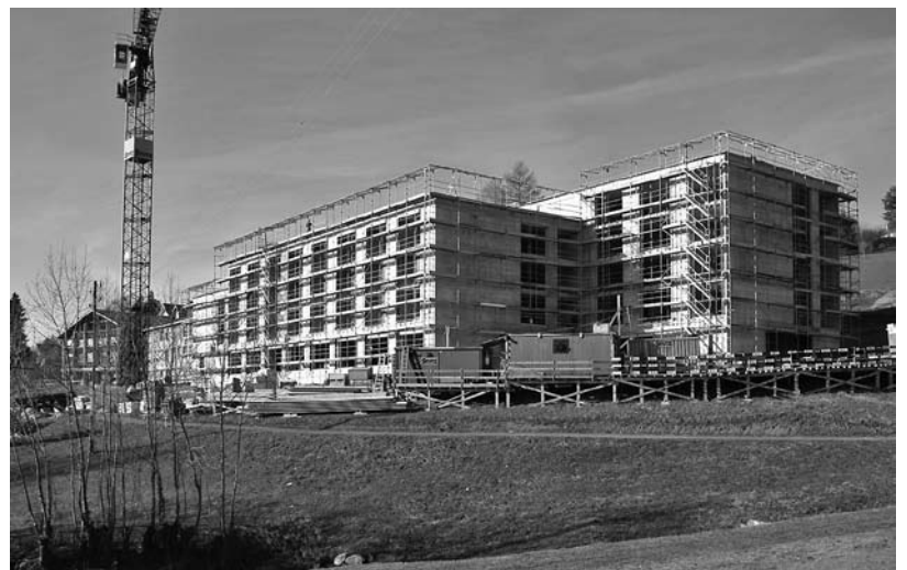
... und der eingerüstete Neubau.
