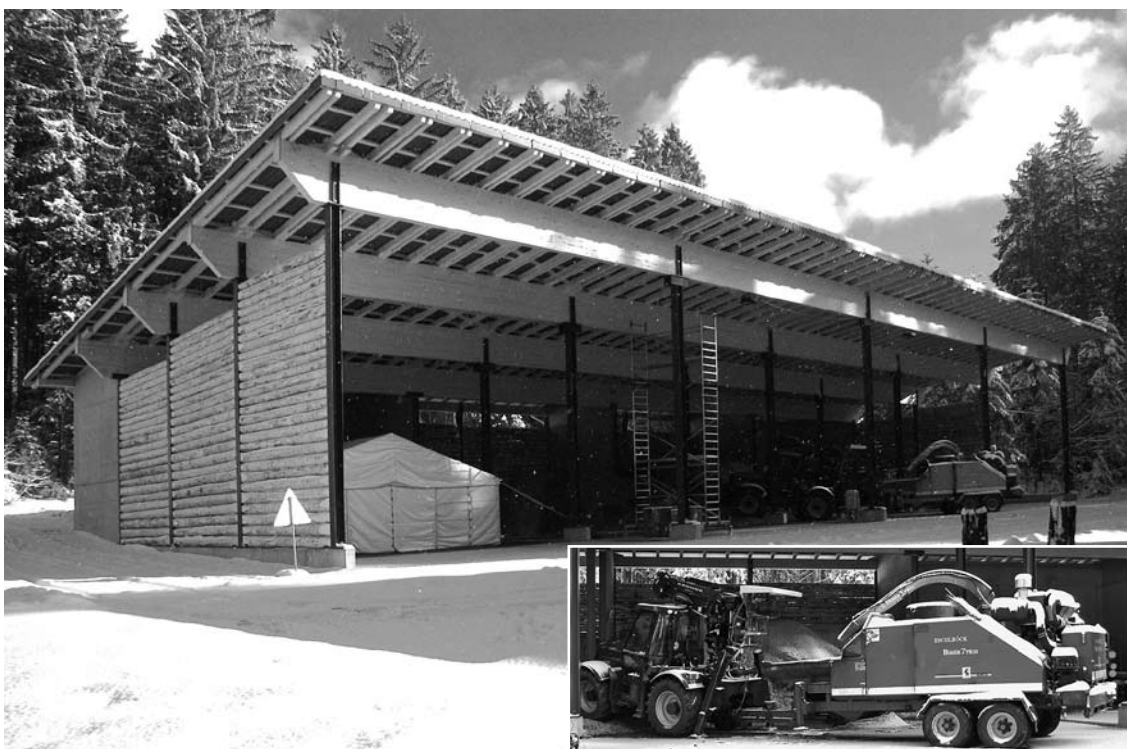
Die neue Holzsnitzelhalle im Steineggwald konnte dem Betrieb übergeben werden; im kleinen Bild die Häcksel-Maschine des Forstamtes Gais. Fotos: GL
