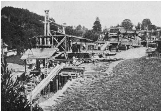
Kiesaufbereitung und Betonmischanlage, 1908.
