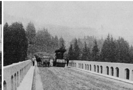
Belastungstest mit der Dampfwalze, 1908.
