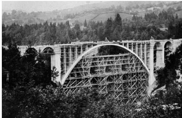
Die neue Gmündertobelbrücke im Bau, 1908.
