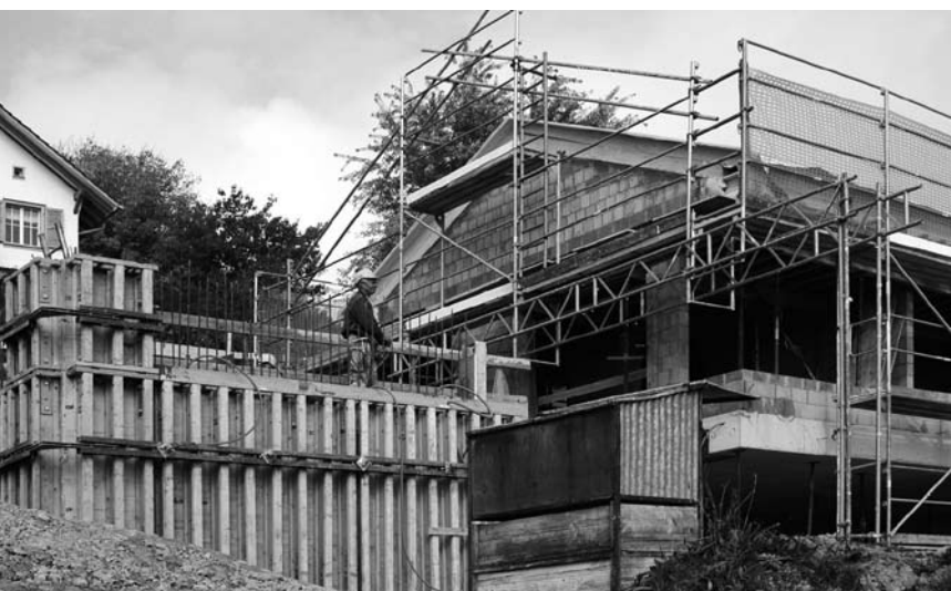
Aufrichte der ersten Einfamilienhäuser an der Fadenrainstrasse. Foto: GL
