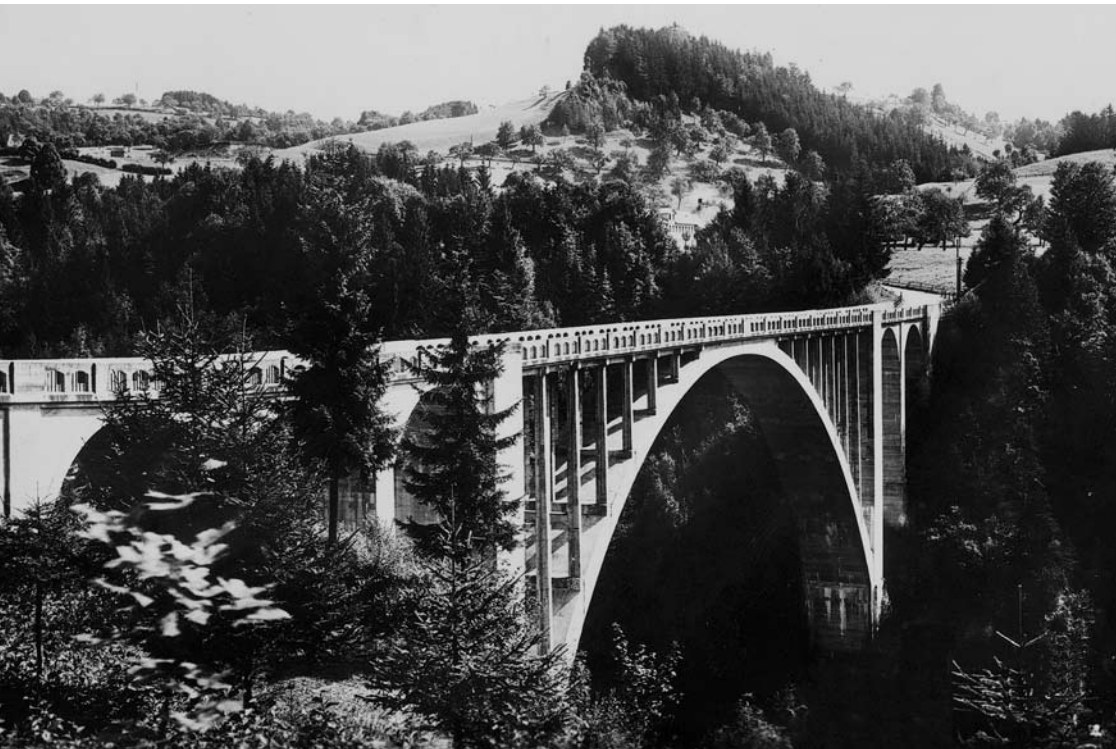
Neue Gmündertobelbrücke. Bemerkenswert ist auch das schön gestaltete Geländer aus Beton.
