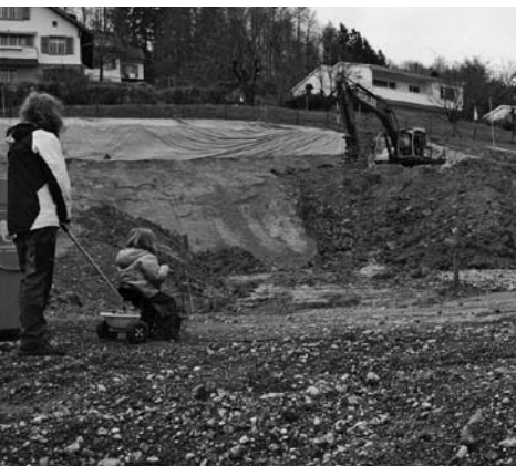
Baubeginn für die Einfamilienhäuser an der Fadenrainstrasse.
