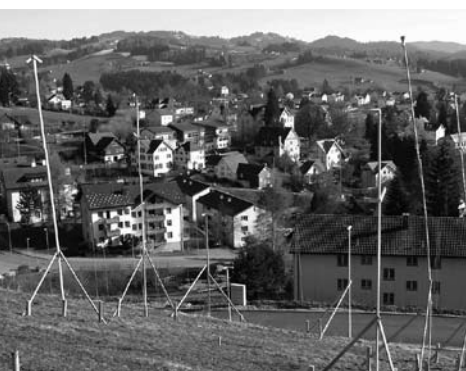
An der Fadenrainstrasse wird gebaut. Foto: GL
