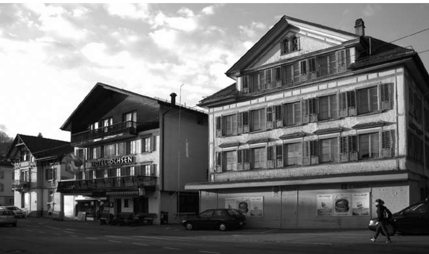
«Ochsen»-Überbauung: Warten auf die Verlegung des Hörli-Baches.
