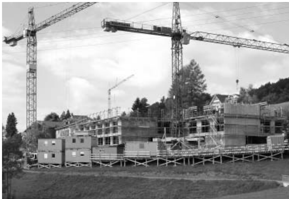
Die Bauarbeiten am Alterszentrum Gremm schreiten zügig voran. Fotos: GL
