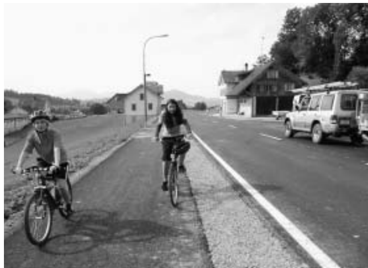
Letzte Bauarbeiten im Bereich der Abzweigung zur «Waldegg».
