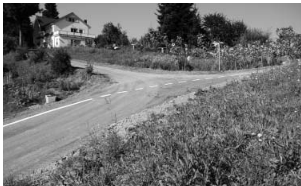
Die erneuerte Bündtstrasse bei der Abzweigung zur «Frohen Aussicht». Foto: GL
