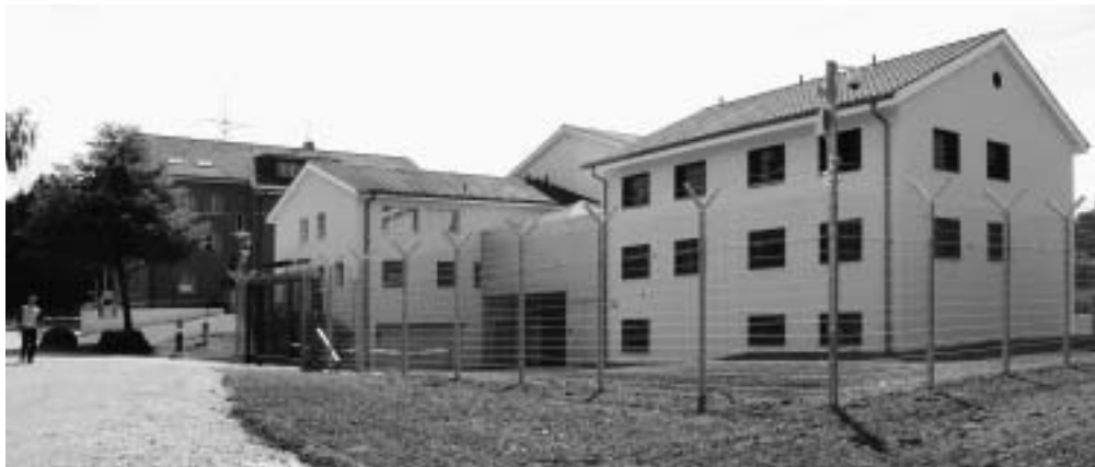
Das neue Kantonale Gefängnis (rechts) in Gmünden. Fotos: GL
