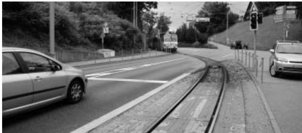
Im Riethüsli wird an der Strasse und am AB-Bahnübergang gearbeitet. Foto: GL
