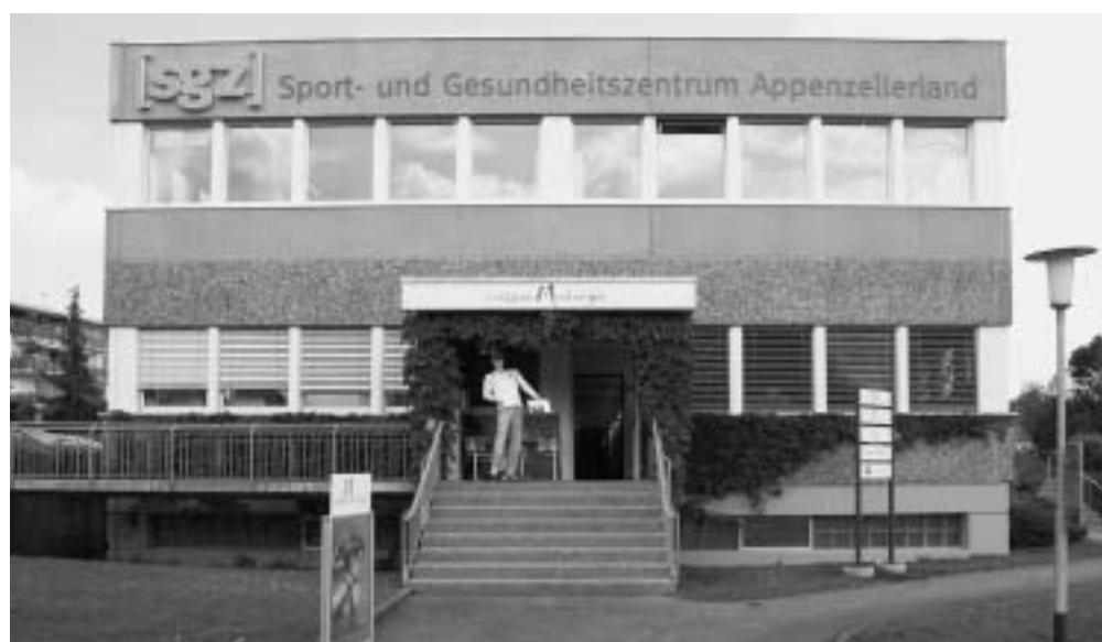
Das neue Sport- und Gesundheitszentrum (SGZ) an der Landhausstrasse 1. Foto: GL
