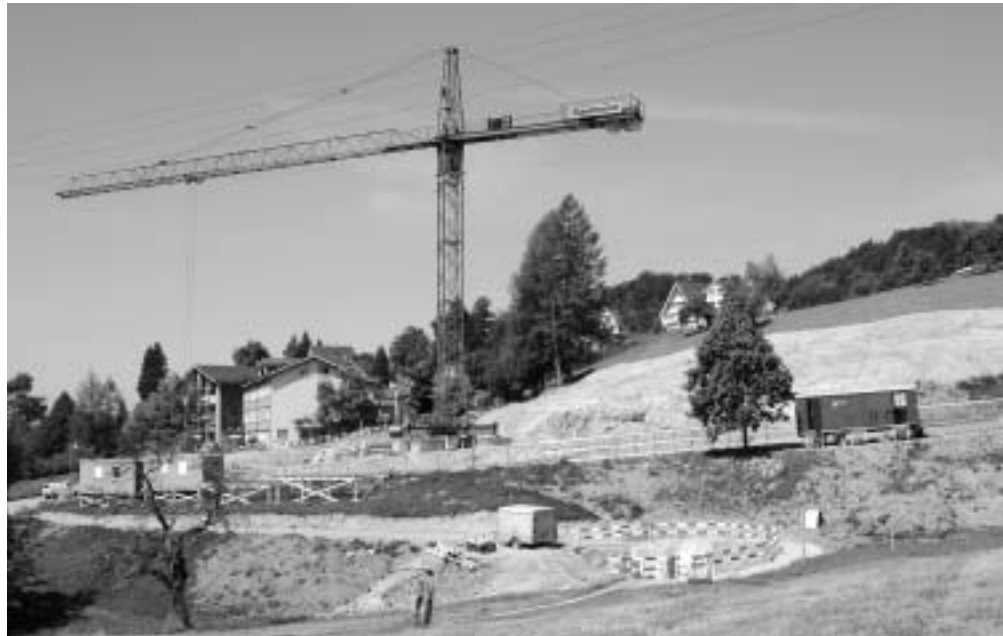
Die Bauarbeiten im Gremm sind in vollem Gang. Foto: GL
