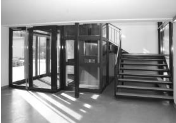
Mit dem «Foyer» im Anbau konnte Zugang in den «Klötzlikeller» und die Räume im Untergeschoss geschaffen werden. Ein Lift führt ins obere Geschoss.
