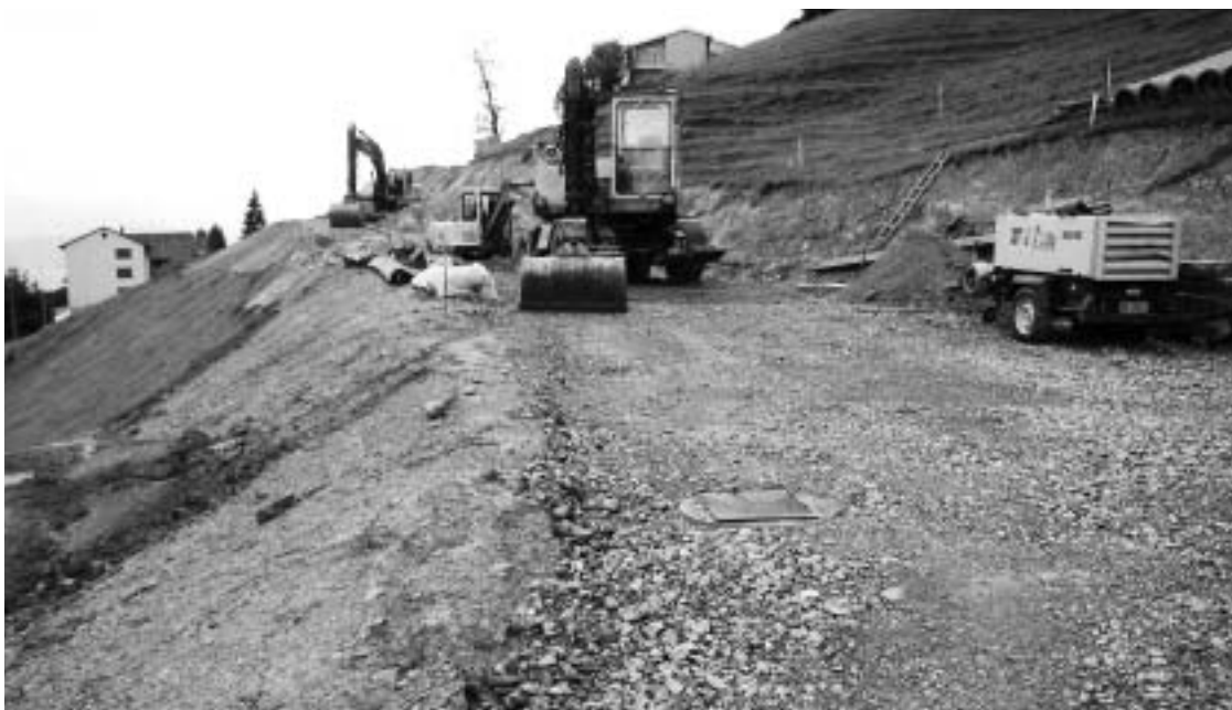
Die Erschliessungsstrasse für das neue Baugebiet Fadenrain ist im Bau. Foto: GL
