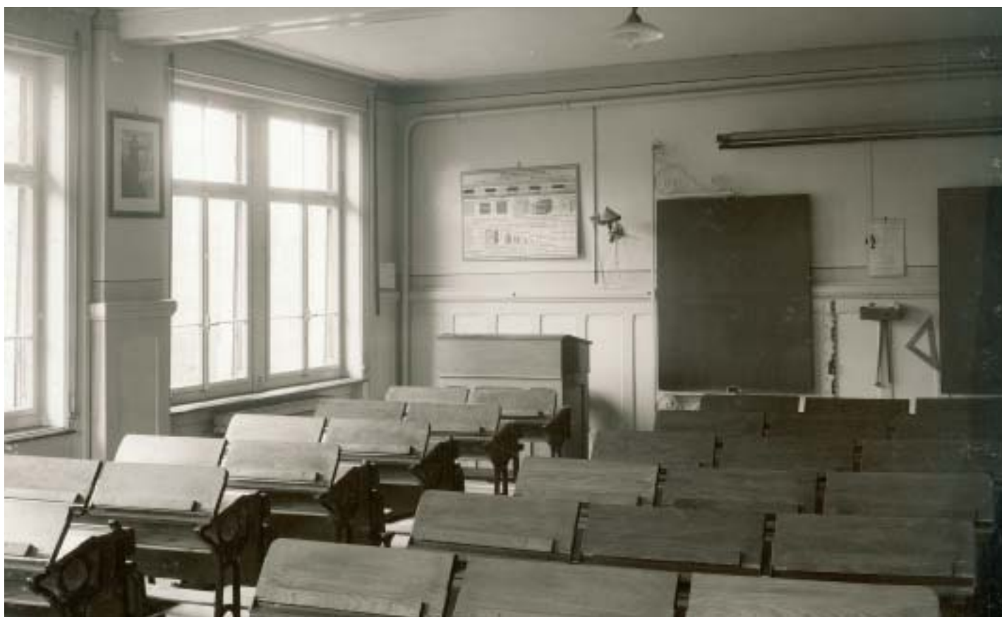
Schulhaus Hörli, Oberschulzimmer, 1914.
