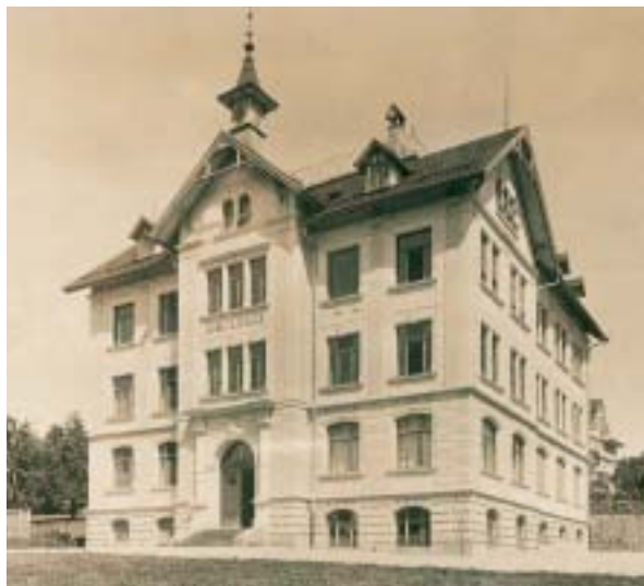
Ansicht des neuen Schulhauses mit dem westseitigen Hauptportal. Archiv Werner Holderegger, Teufen
