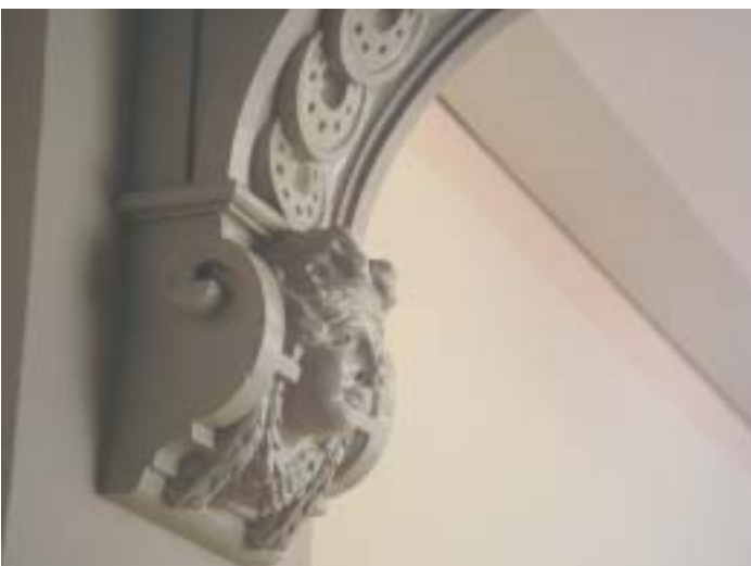
Liebenswerte Details aus der Bauzeit im Gang...
