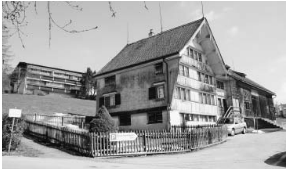
Das Bauernhaus Preisig und das Schwesternhaus müssen abgebrochen werden. Foto: GL
