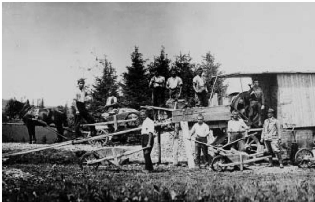
Eine mobile Steinbrechmaschine zerkleinerte die Bruchsteine zu Koffermaterial für das Strassenbett. Ende 1920er Jahre.
