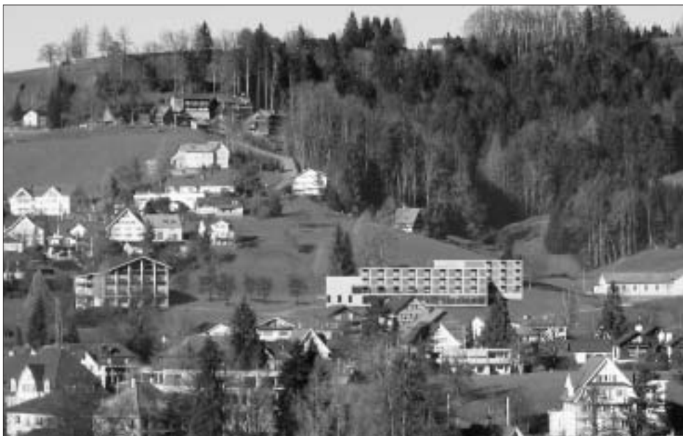
Das neue Alterszentrum Gremm (Bildmitte) soll sich harmonisch in den Südhang einfügen. Bildmontage: zVg.
