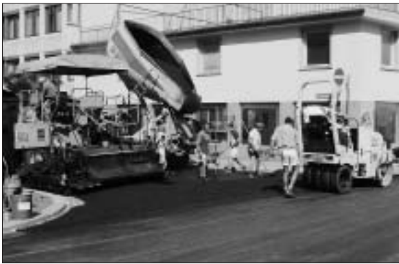
Belageinbau an der Gartenstrasse in St. Gallen. Foto: pd.
