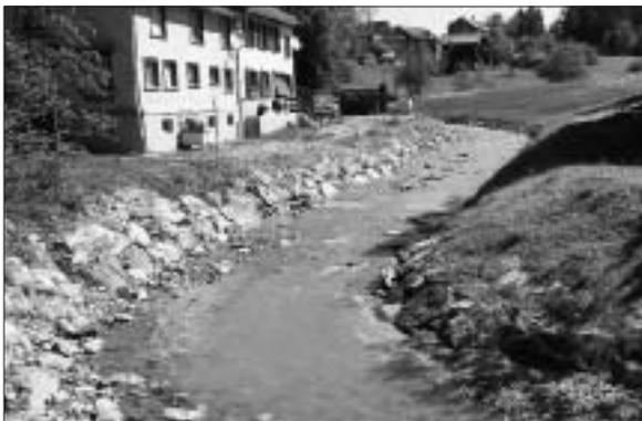
Ein Beispiel: Der Goldibach wurde bei der Goldibücke abgeseigt, damit das Wasser schneller fliesen kann. Die Böschungen wurden mit grossen Felsquadern gesichert. Foto: GL
