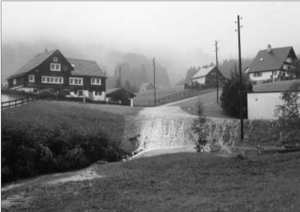
Hochwasserbild vom 1. September 2002 bei der Trinkwasseraufbereitungsanlage Wetti. Foto: zVg.
