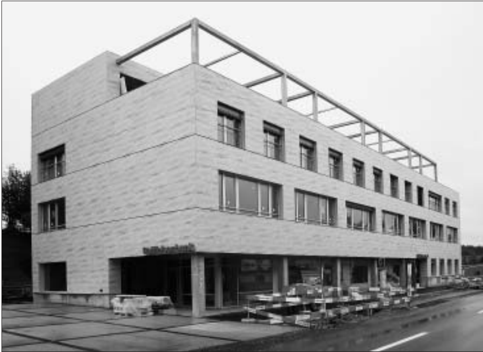
Das neue Domizil der Raiffeisen-Geschäftsstelle Teufen; der Neubau beim Bahnhof. Fotos: GL
