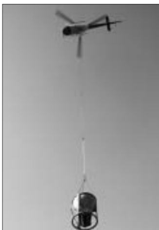
Mit dem Heli wurden 35 Kubik Beton ins Rotbachtobel hinunter geflogen. Foto: GL
