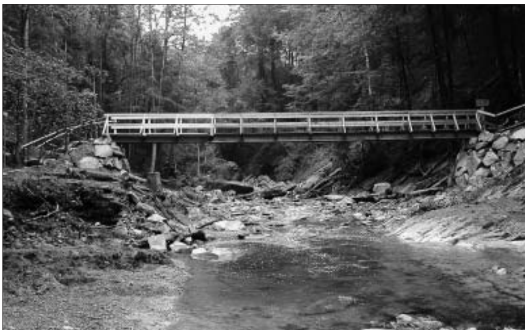
Etwa 5 Meter flussaufwärts und rund 1 1/2 Meter höher ist der neue Höchfall-Wanderwegsteg neu aufgebaut worden.
