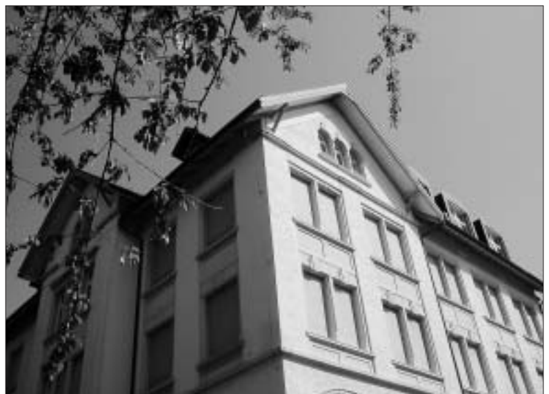
Im Schulhaus Hörli stehen Teilsanierungen an.
