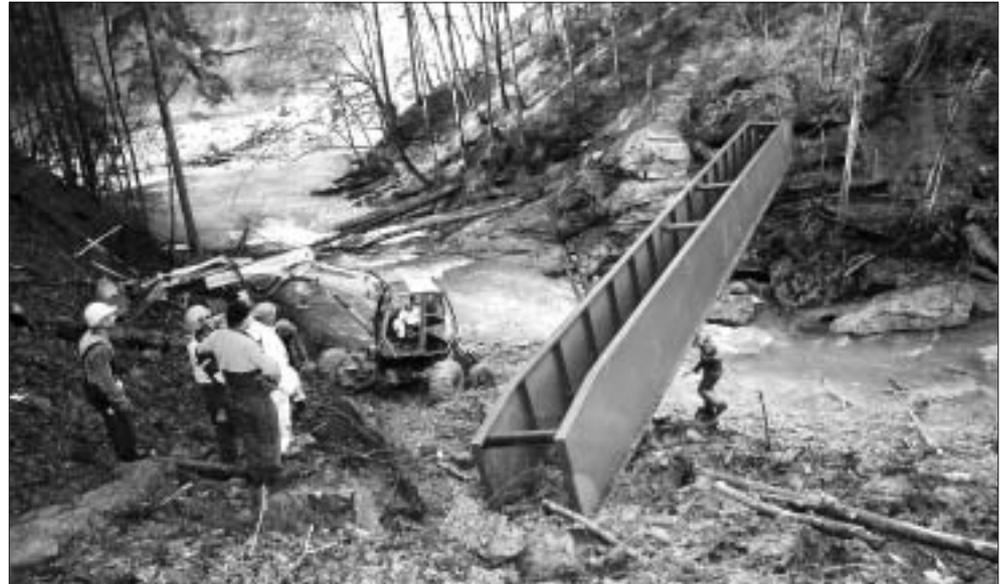
130 Meter tiefer wird die Metallkonstruktion auf die Auflager gelegt.
