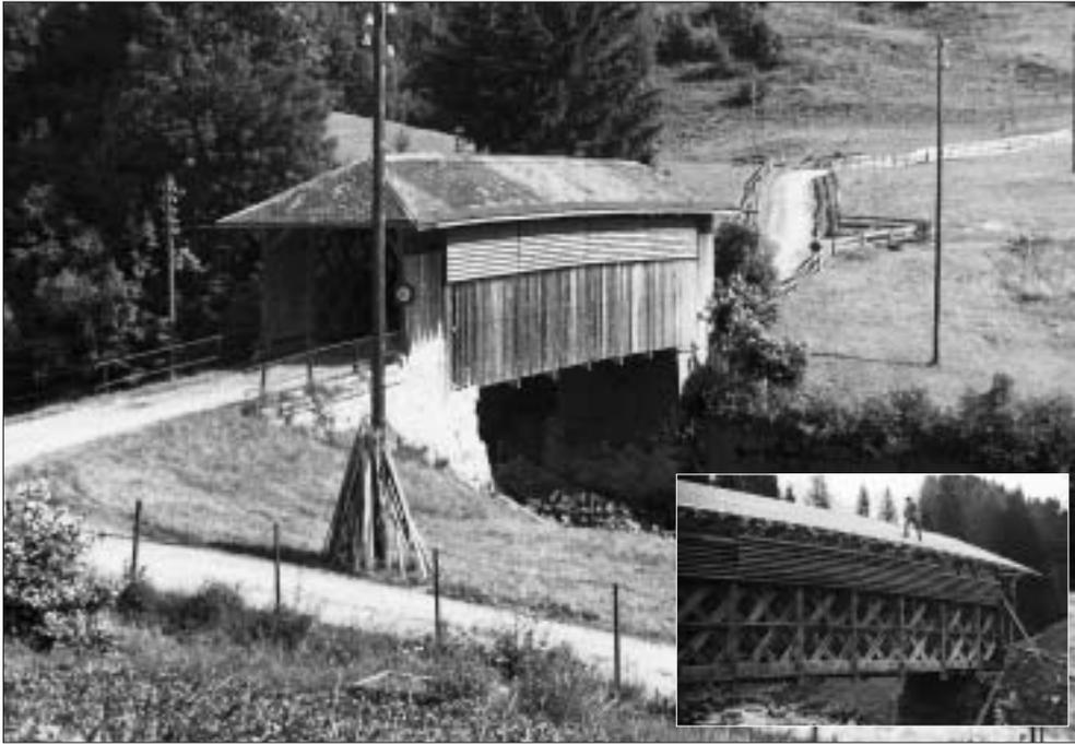
Die Seltene: Town'sche Gitterträgerbrücke am alten Standort beim Übergang über den Rotbach in die Göbsi und beim Wiederaufbau in der Oberen Lochmüli (kleines Bild).
