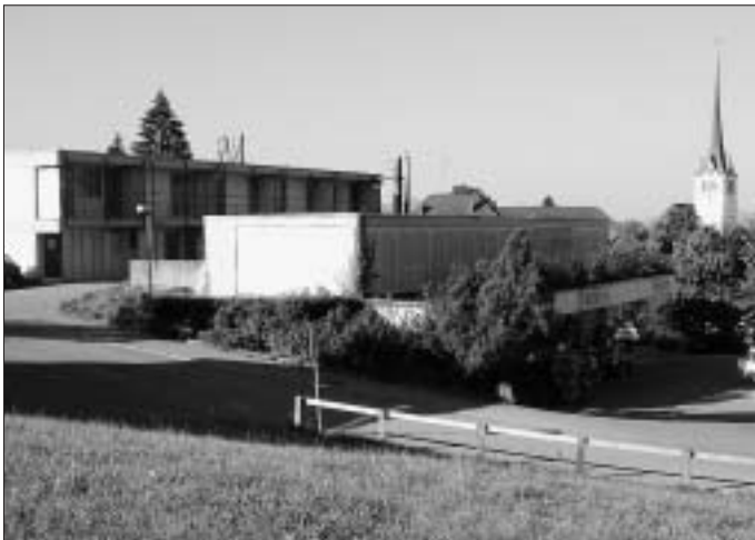
Die Migros-Liegenschaft soll nach dem Besitzerwechsel aufgestockt und die Ladenfläche vergrössert werden. Foto: GL
