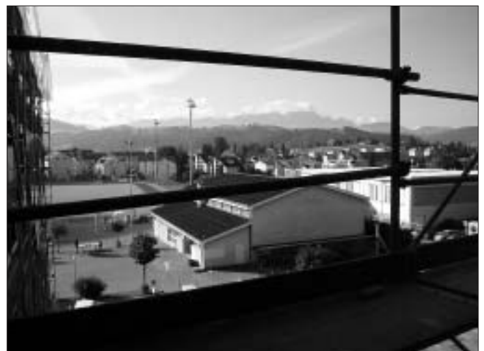
Schöne Aussichten... sind bereits aus dem Rohbau zu geniessen.
