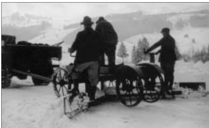
«Hobeln der Fahrbahn» auf der Staatsstrasse von Teufen nach Bühler, 1931. Silbergelatine-Abzug, 122 x 173 mm. Unbekannter Fotograf.
