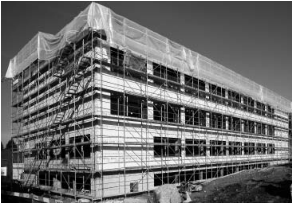
Das neue Schulhaus Landhaus von Südosten her gesehen; die Südfassade ist bereits mit Schindeln gedeckt.
