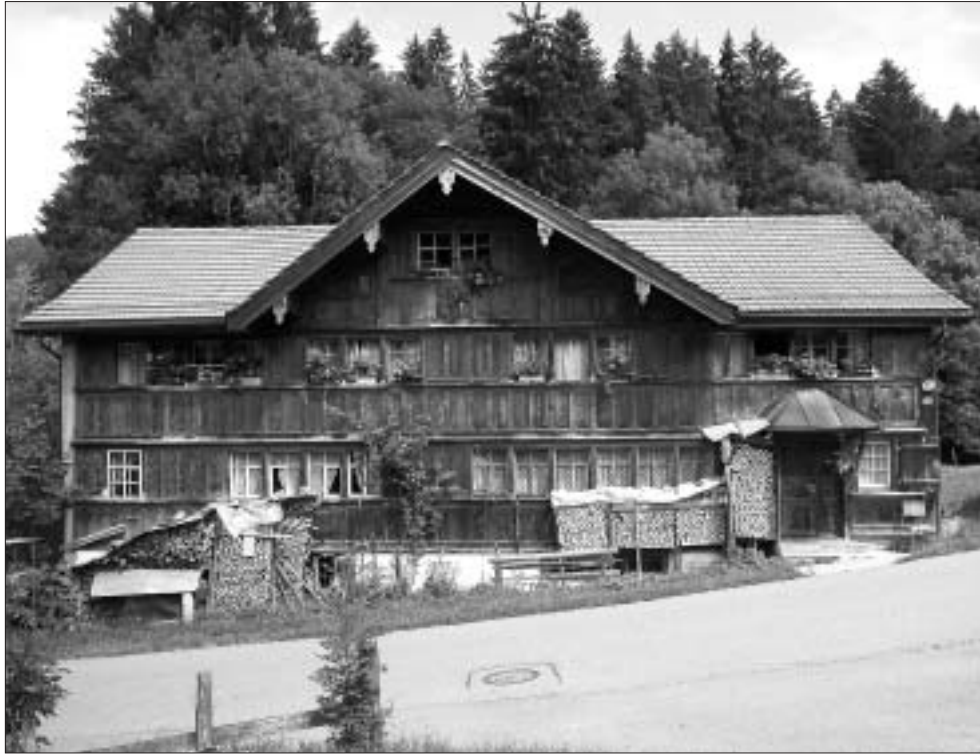
Die Beckenmüli war früher ein Heidenhaus, später wurde ihm ein Mittelgiebel aufgesetzt.
