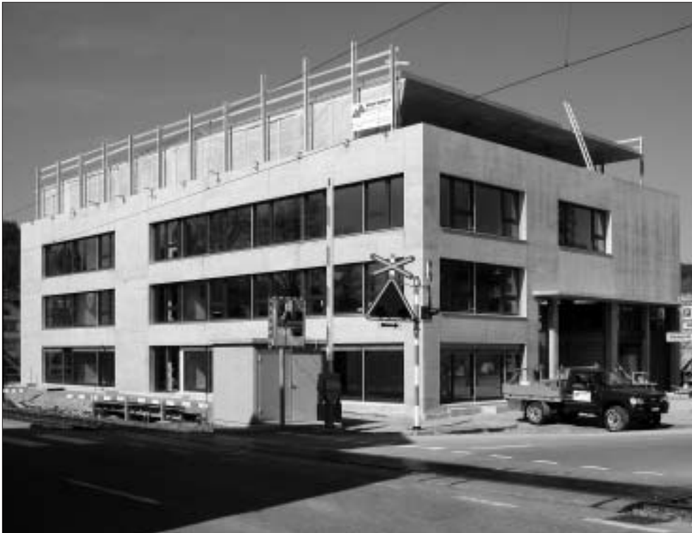
Im neuen Werkhof der Mettler + Tanner AG wurde der Betrieb aufgenommen. Fotos: GL
