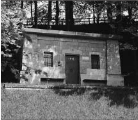
Die Reservoirs Schlipf 1 (1912) und Hüslers-egg (1923) sowie die Aufbereitungsanlage Wetti (1972, rechts).
