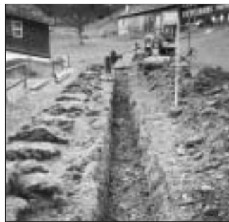
Bau einer Abwasserleitung ausserhalb der Bauzone. Foto: zVg.
