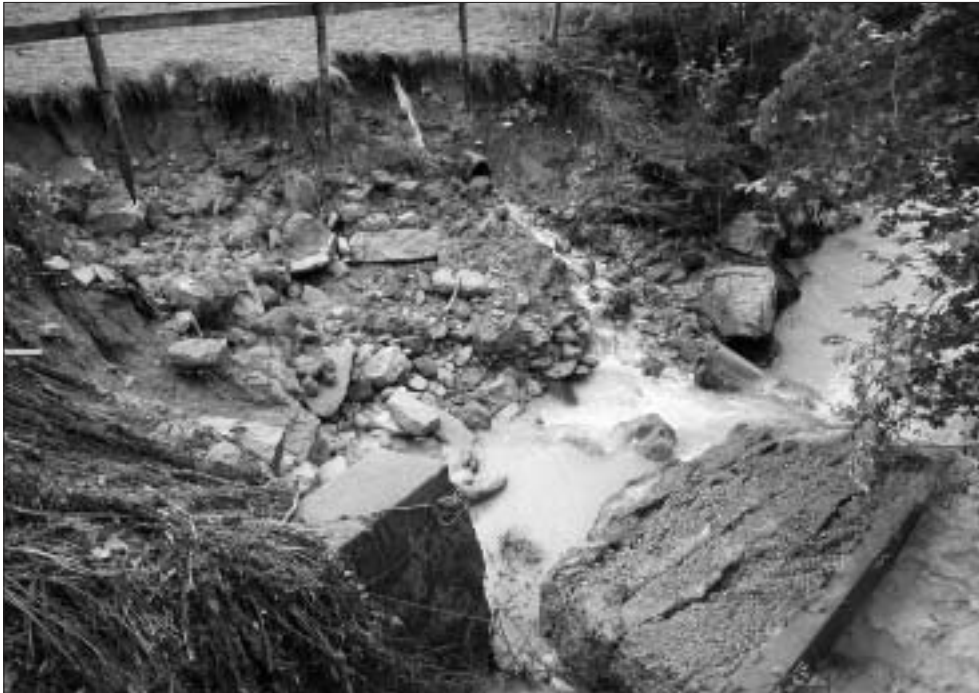
Bei der Beckenmüli (Zellweger, Alte Speicherstrasse) hat das Hochwasser Uferböschungen und Mauerteile mitgerissen.
