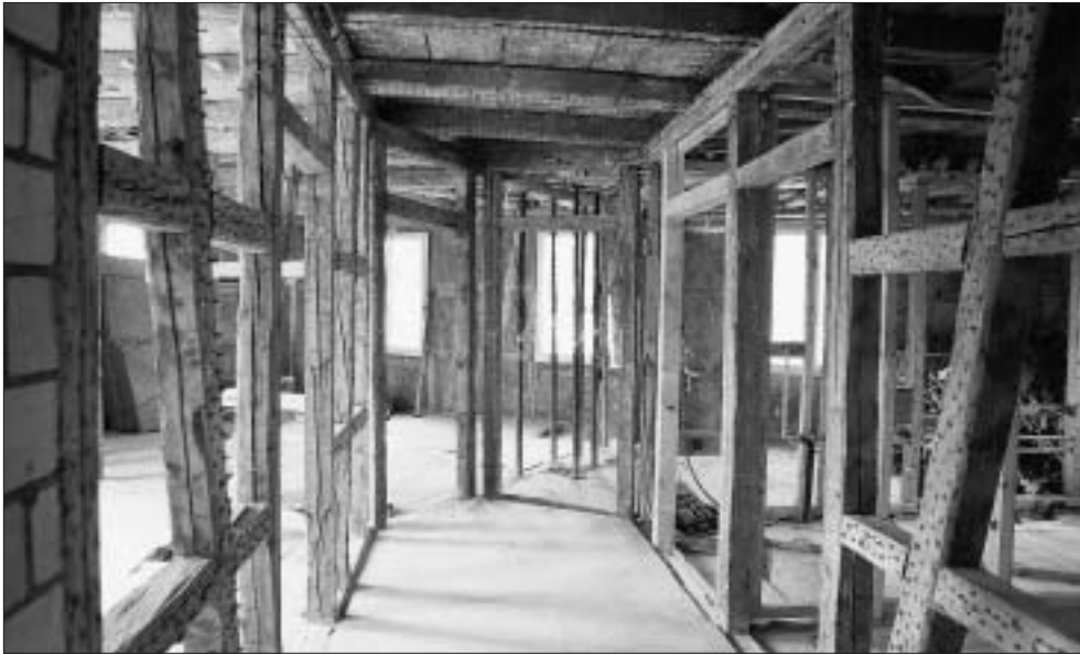
Zwei Bilder vom Umbau im 1. Obergeschoss: Abbruch der alten Riegelkonstruktion...
