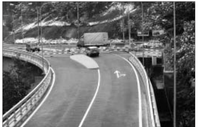
Für den Verkehr gerüstet: Die Ein-/Ausfahrt der Umfahrungsstrasse in der Lustmühle.
