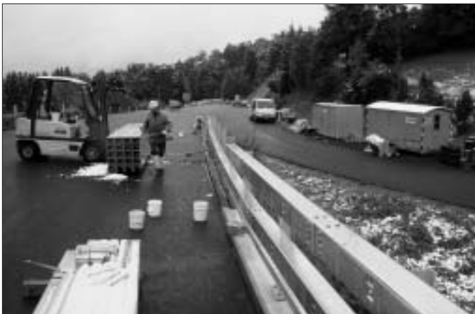
Letzte Arbeiten auf der Brücke und bei der Ein-/Ausfahrt Hinterbüel.
