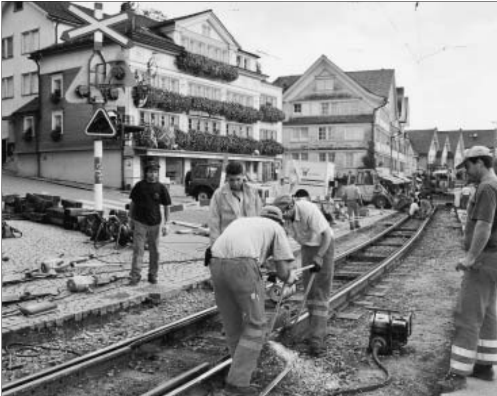
Der Gleisumbau im Dorfzentrum wird während rund einer Woche zu Umstellungen führen. Archivbild: GL
