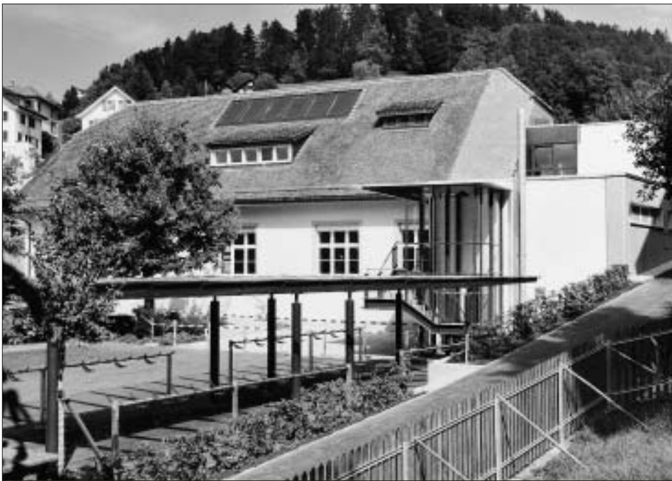
Die «neue» Dorfturnhalle mit dem Neubau trakt (rechts). Foto: GL
