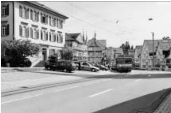
Die Sanierungsarbeiten der Appenzeller Bahnen im Dorfzentrum finden nicht während den Sommerferien statt.
