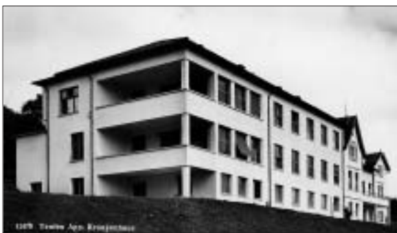
Der Neubau, 1939 bezogen, von Architekt Adolf Kuhn, Arbon / Taufen, mit offenen Liegeveranden. Foto: Sammlung Werner Holderegger
