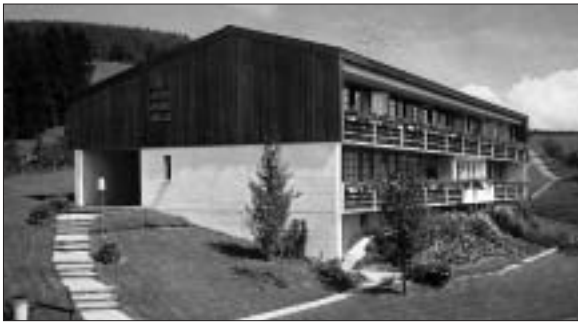
Das hübsche Schwesternhaus von 1963 der Architekten Heeb und Wicki, St. Gallen, in reichem Blumenschmuck.
