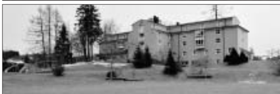
Ehemaliges Spital oder Lindenhügel: Wo soll das Alterszentrum realisiert werden? Fotos: GL
