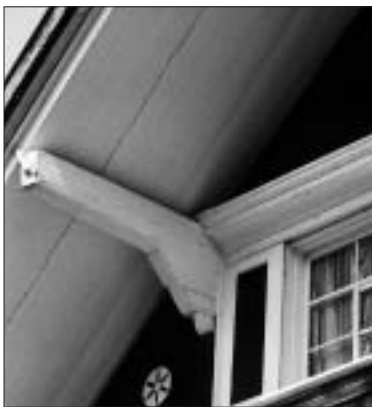
Gstalden (Haus Mevius). 17. Jahrhundert, einfach schräge Pfettenkonsole.
