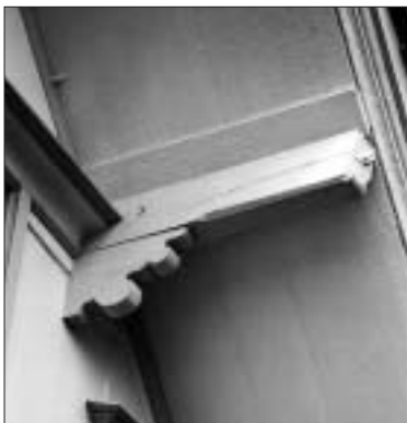
Gremmstrasse (Paradiesli, datiert 1779). 18. Jahrhundert, barocke, reich geschweifte Pfettenkonsole.
