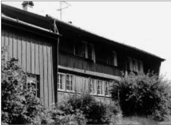
Schäfliegg: traufständiges Heidenhaus mit später angebautem Stadel.
