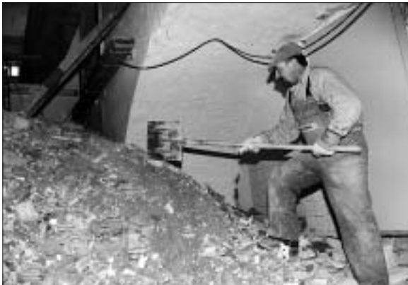
Das Gemeindehaus – hier der Keller – wird für den Lifteinbau «ausgehöhlt».
