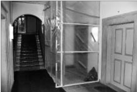
Hier entsteht der neue Lift für das Gemeindehaus.
