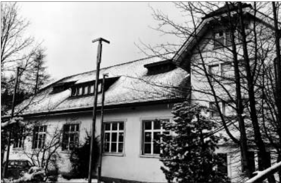
Die Turnhalle Dorf muss wegen des schlechten baulichen Zustandes saniert werden. Auf der Ostseite (rechts) soll ein neuer Eingang entstehen. Fotos: GL
