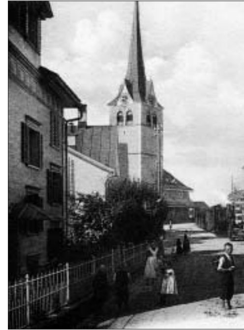
An der Stelle des Sportgeschäftes Wako bestand um 1900 eine Telefonzentrale. Manser weist auf die erste Telefonzentrale in Teufen hin. Später wurde die Zentrale an die gegenüberliegende Seite verlegt. Die alte Seite musste wegen der Strassenverbreiterung zurückversteigert werden.
