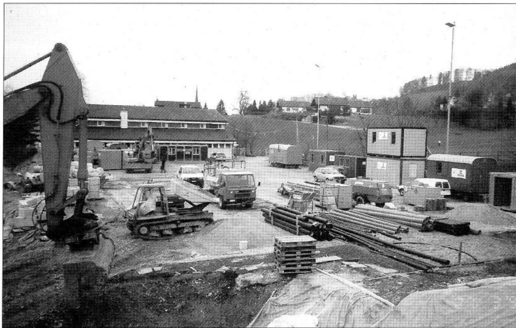
Beginn der Bauarbeiten im Landhaus. Fotos: Jürg Thurnheer
