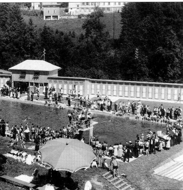
Der elegante Sprungturm in Betonkonstruktion. Fotos: Baumeister-Familie Bruderer
