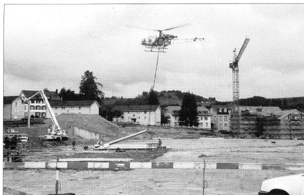
Mit Helikopter werden die Lichtmasten aufgestellt.
