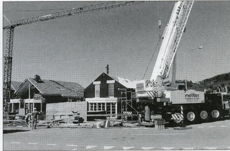
Innert weniger Tage entstanden vier Einfamilienhäuser im Bereich Bächlistrasse/Schönenbüel; drei weitere sind im Bau, zwei sind geplant.
