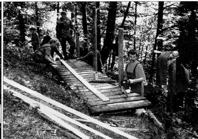
Wanderweg Wonnenstein – Rotbach – Hinterhaslen: Erstellen eines neuen Steges. Fotos: WH
