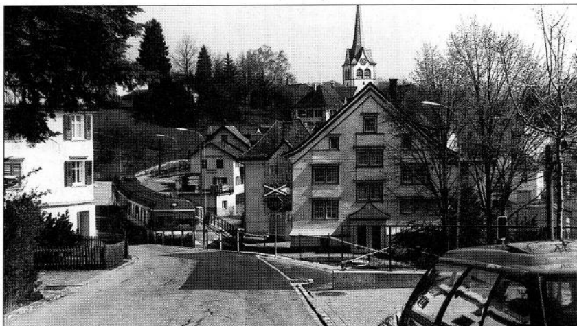
Der Einlenker Unter- rain/Schützenberg- strasse/Hauptstrasse (im Bild vom Haus Leng- weiler aus gesehen) wird mit einem Rechts- abbiegeverbot und einer Ampel signalisiert.
