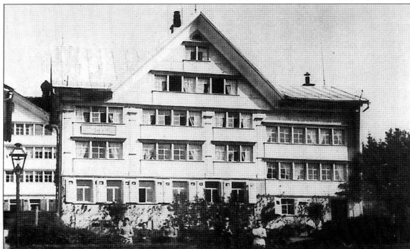
Die Südfassade des stattlichen Hauses im Originalzustand um 1930.
